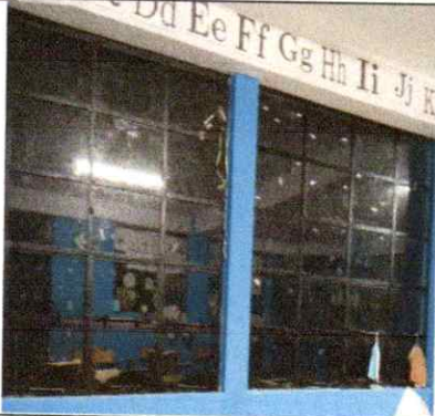
Foto 3: Ventanas, sustitución de vidrios
