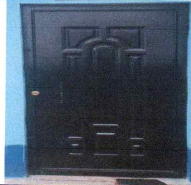
Foto 2: Puerta de metal, Sustitución de puerta de metal
