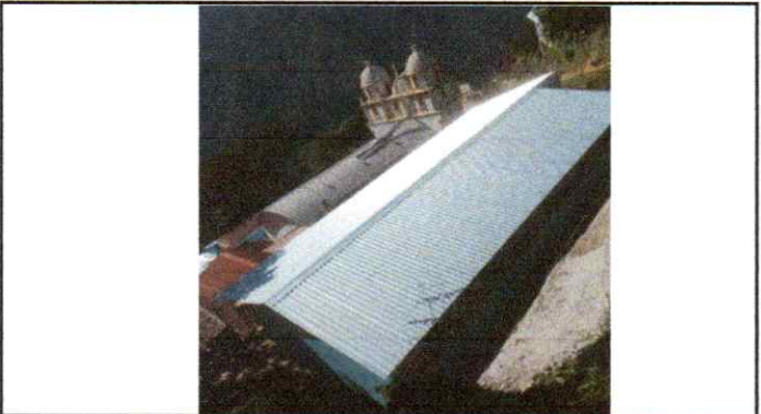
Foto 8: sustitución de laminas acanaladas y o troqueladas en el aula
