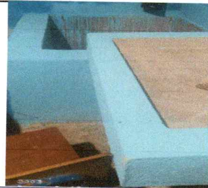
Foto 4: Reparación de cocina, sustitución de pila de cemento de un lavadero
